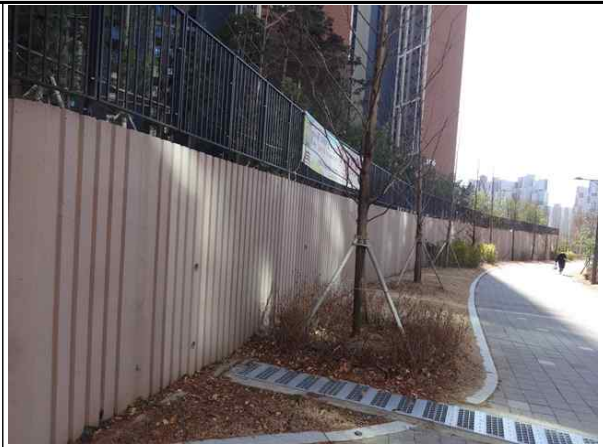
L형 옹벽 종점부
