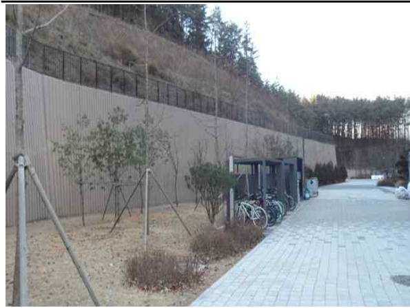
역L형 옹벽 시점부
